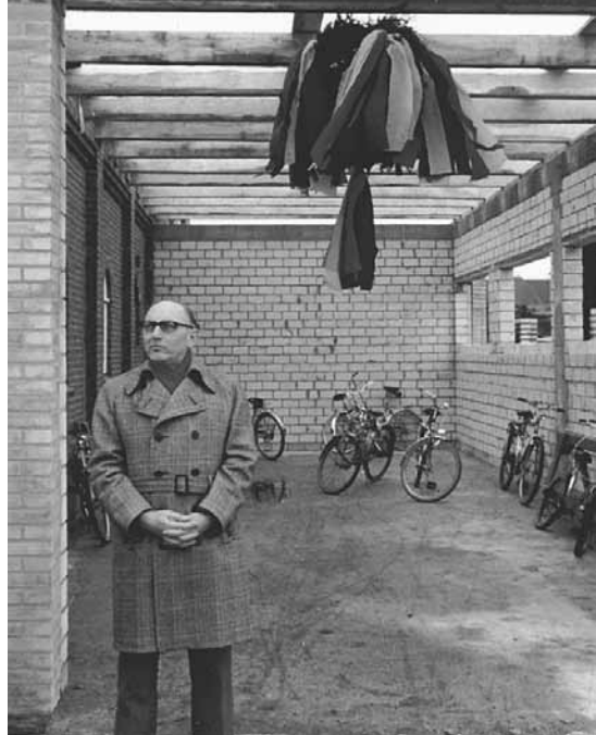
1792 Richtfest – Richtansprache durch stellvertr. Bürgermeister Heinz Brich
