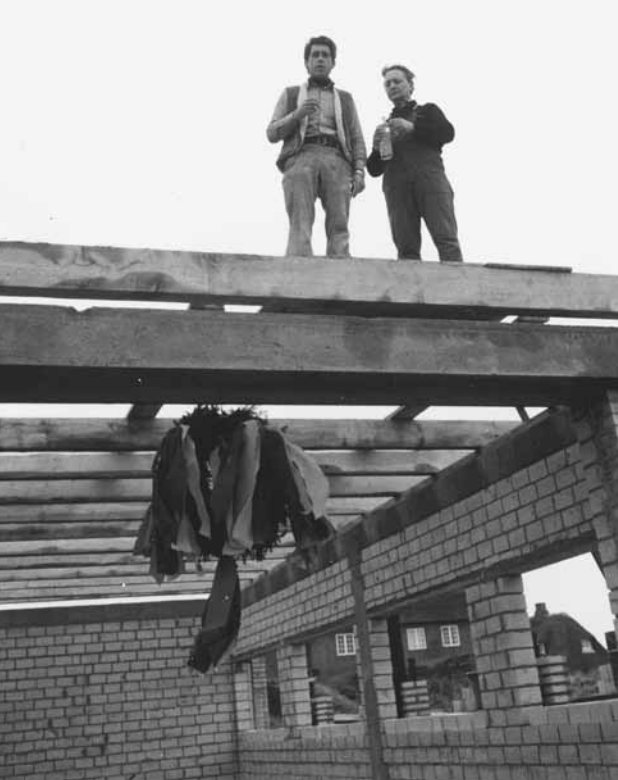
1972 Richtfest Anbau an den Rettungsschuppen – Richtspruch mit Alfred Ludwigsen, Harry Knuth
