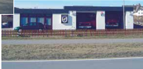
Neues Gerätehaus ab 1990
