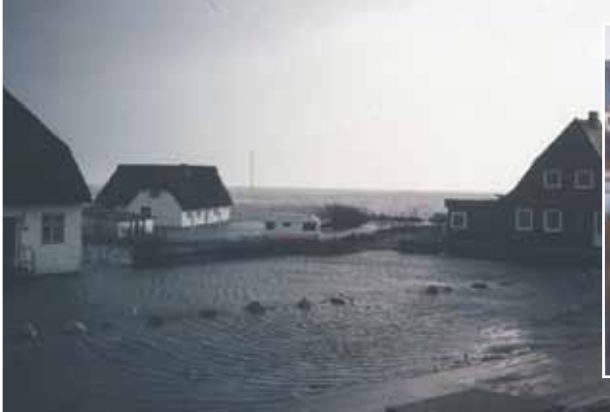
1981 Hochwasser Restaurant »Raan'tem Hüs«
