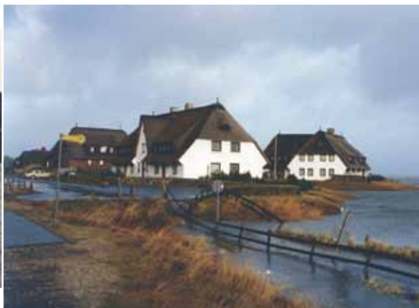
1981 Hochwasser Dorfeingang von Süden
