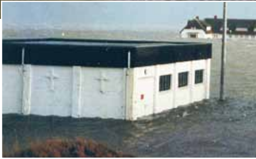
Neues Gerätehaus ab 1972
