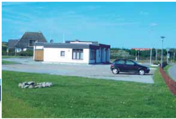
Gerätehaus mit Grundstück
