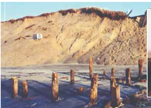
1981 Hochwasser Abbruchkanter an der Haupttreppe
